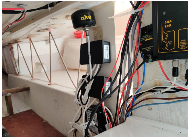
Installation NKE à l'intérieur
