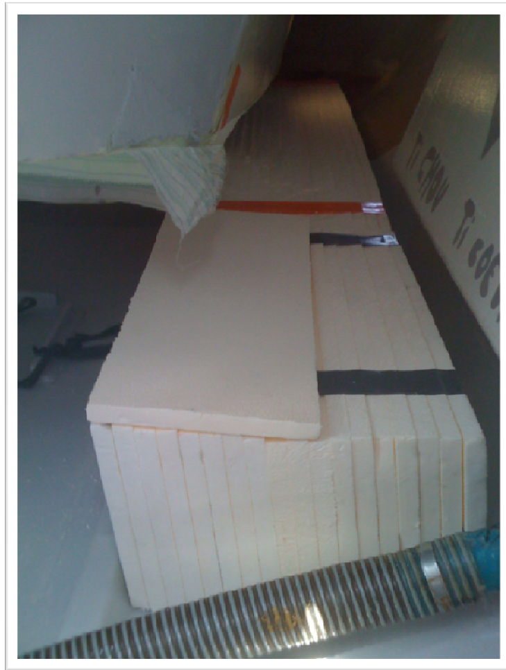
Mise en place du nouveau bloc
