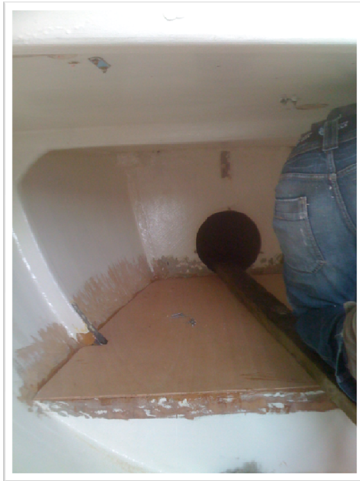
Mise en place du plafond
